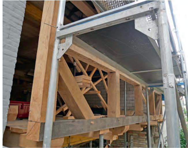
Der Neuaufbau der Traufwand in den Hof erfolgte im Obergeschoss mit Eichenfachwerk auf der neuen Balkenlage. Die Gefache wurden klassisch mit im Haus geborgenen Ziegeln neu ausgemauert. Das neue Fundament im Erdgeschoss wurde auf dem ursprünglichen Steinfundament erstellt. Dazu mussten die Findlinge, jeweils horizontal geschnitten werden. Darauf wurde die Wand mit Porotonziegel erstellt und mit dänischem Schlemmmörtel verputzt.
